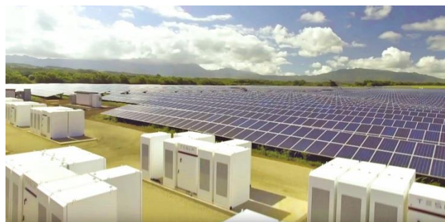
圖 2: Tesla 的 Powerpack 鋰離子電池系統與太陽能電池組合[2]。
